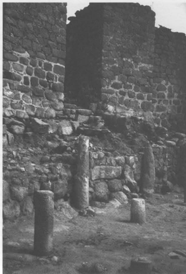
FIG. 3. — Puerta de entrada al recinto principal. En primer plano, restos de la mezquita (cliché del autor)
