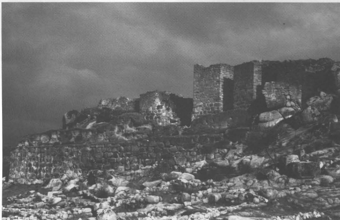
FIG. 4. — Vista del muro de la barbacana rematado en tapial (cliché del autor)
